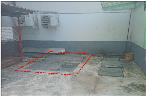
สภาพบ่อดักน้ำ และบ่อดักตรวจคุณภาพน้ำ อยู่ในสภาพดีไม่มีสิ่งอุดตัน
