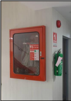
อุปกรณ์ป้องกันอัคคีภัยต่างๆ ไฟส่องสว่างฉุกเฉิน และตู้หัวฉีดน้ำดับเพลิง (FHC)
