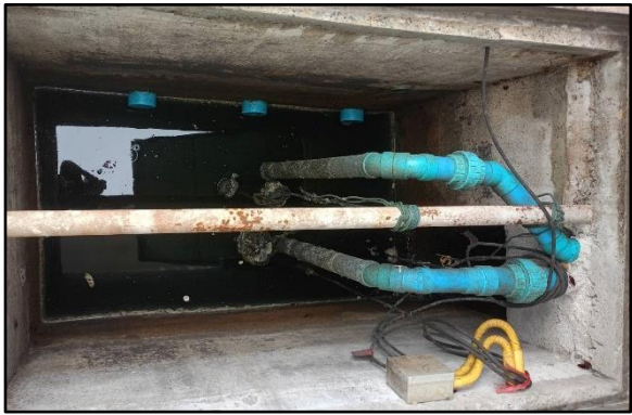
สภาพบ่อดักน้ำ และบ่อดักตรวจคุณภาพน้ำ อยู่ในสภาพดีไม่มีสิ่งอุดตัน
